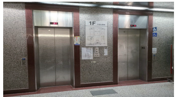
文蒼樓電梯汰舊換新 改善教學活動設施
