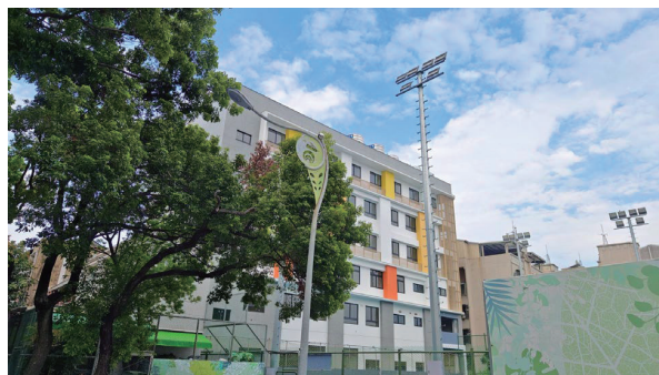
淑慎樓重建工程 營造優質住宿空間
