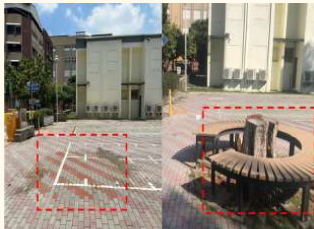
南風停車場枯樹根移除
