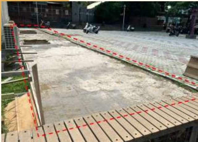
南風停車地坪增建(近完工)
