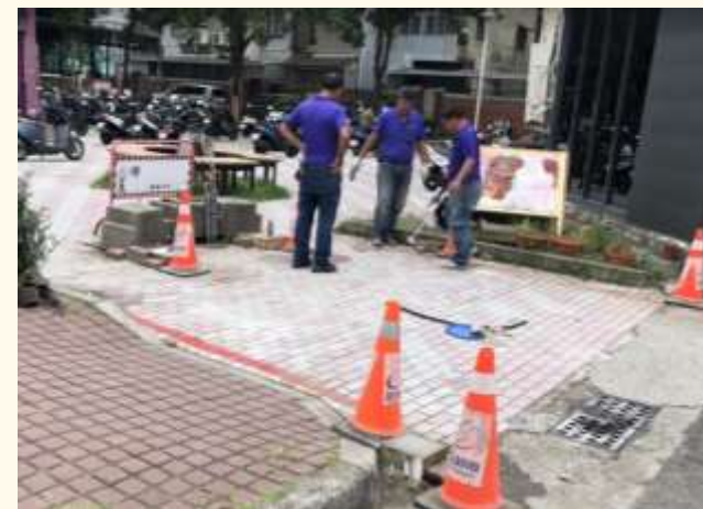
南風停車場-車牌辨識建置
